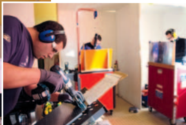
Les trois compétiteurs, casque sur les oreilles, réalisent un exercice de câblage.
